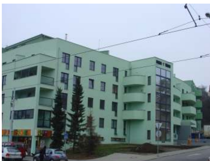
BYTOVÝ DŮM PRAHA
